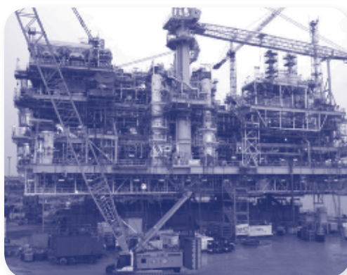
Figura 5. Mantenimiento en uso u operación en una instalación terrestre
