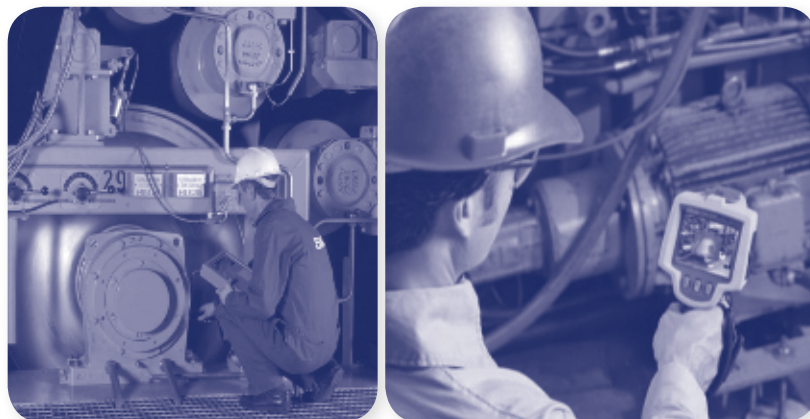
Figura 9. Empleo de vibrómetro y cámara termográfica durante el funcionamiento de equipos
