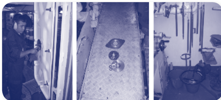
Figura 15. Mantenimiento Preventivo de una puerta estanca y sus accesorios a bordo del Buque Escuela ARC "Gloria".
