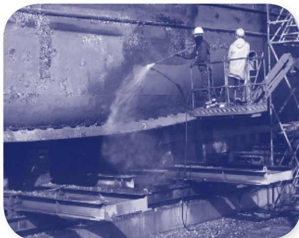
Figura 8. Limpieza de casco
