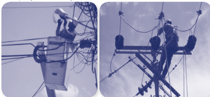
Figura 13. Mantenimiento Preventivo a redes eléctricas
